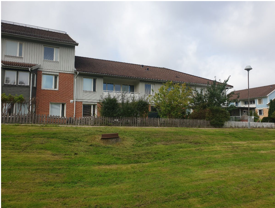
Figur 20 Befintlig bebyggelse angränsande till norra planområdet. Bild: Exploateringsförvaltningen
